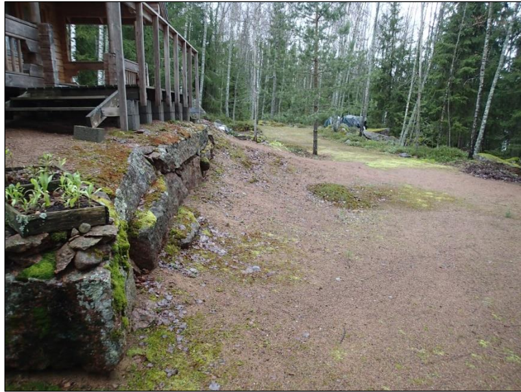
Kirskallionniemellä sijaitsevan mökin kivijalkaa ja pihaa. Länteen.
